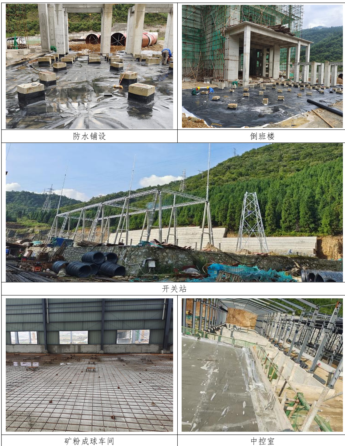
工程 2021 年 4 季度现场照片
