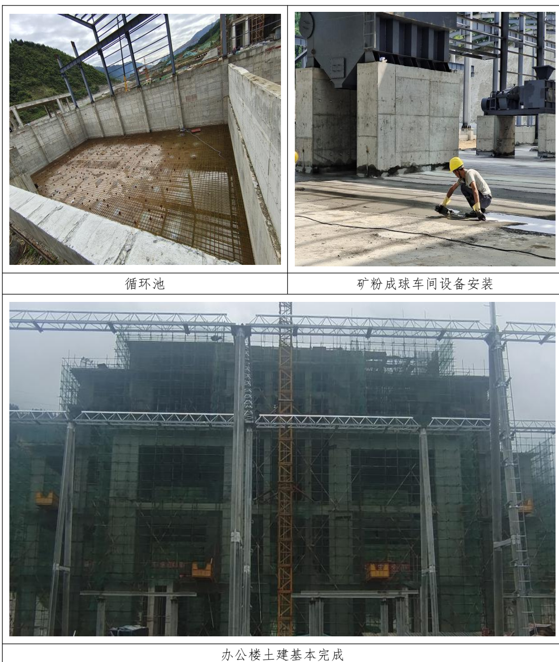
工程 2023 年 1 季度现场照片
