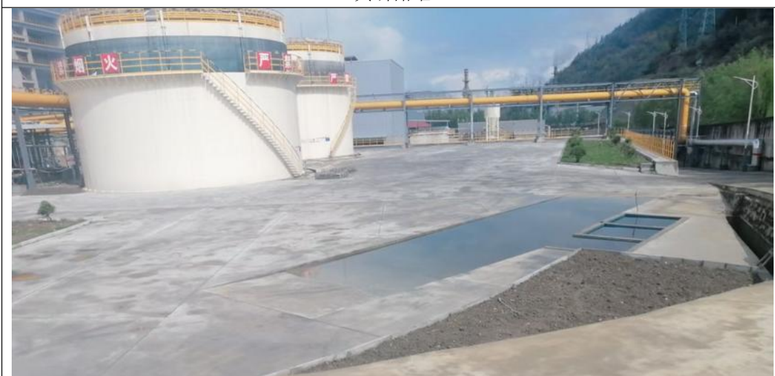
气罐及道路广场
